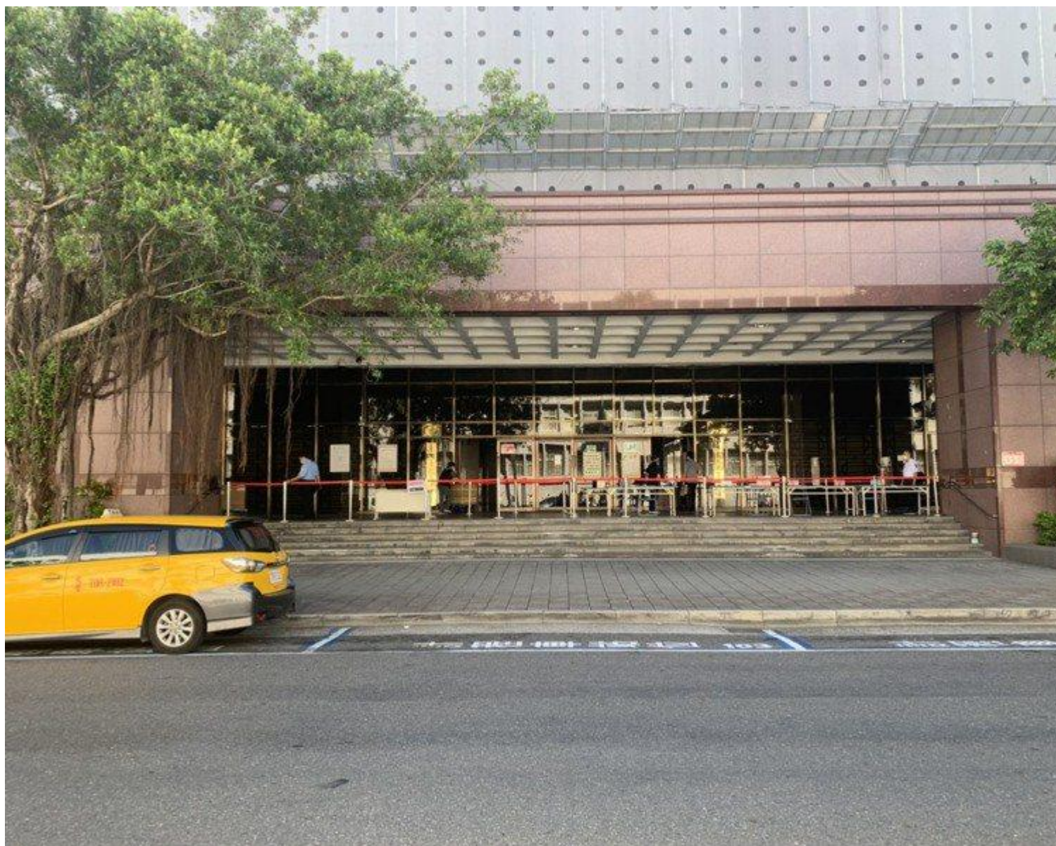
台北地方法院。圖／聯合報系資料照客戶水電保全
